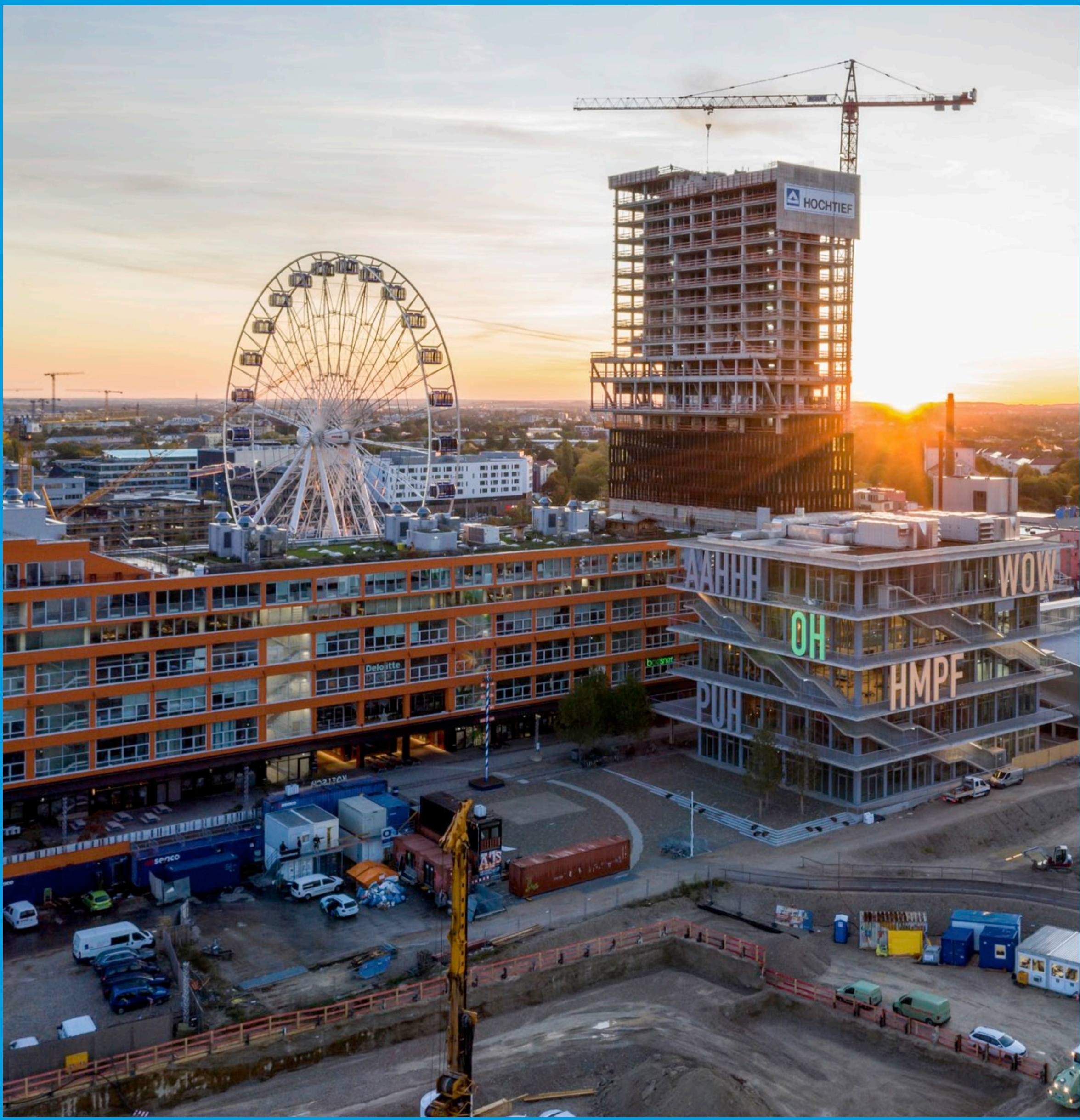
07 Werk4 – Umbau des 30 m hohen Kartoffelmehlsilos in ein Hostel und Aufstockung zur Nutzung als Hotel
