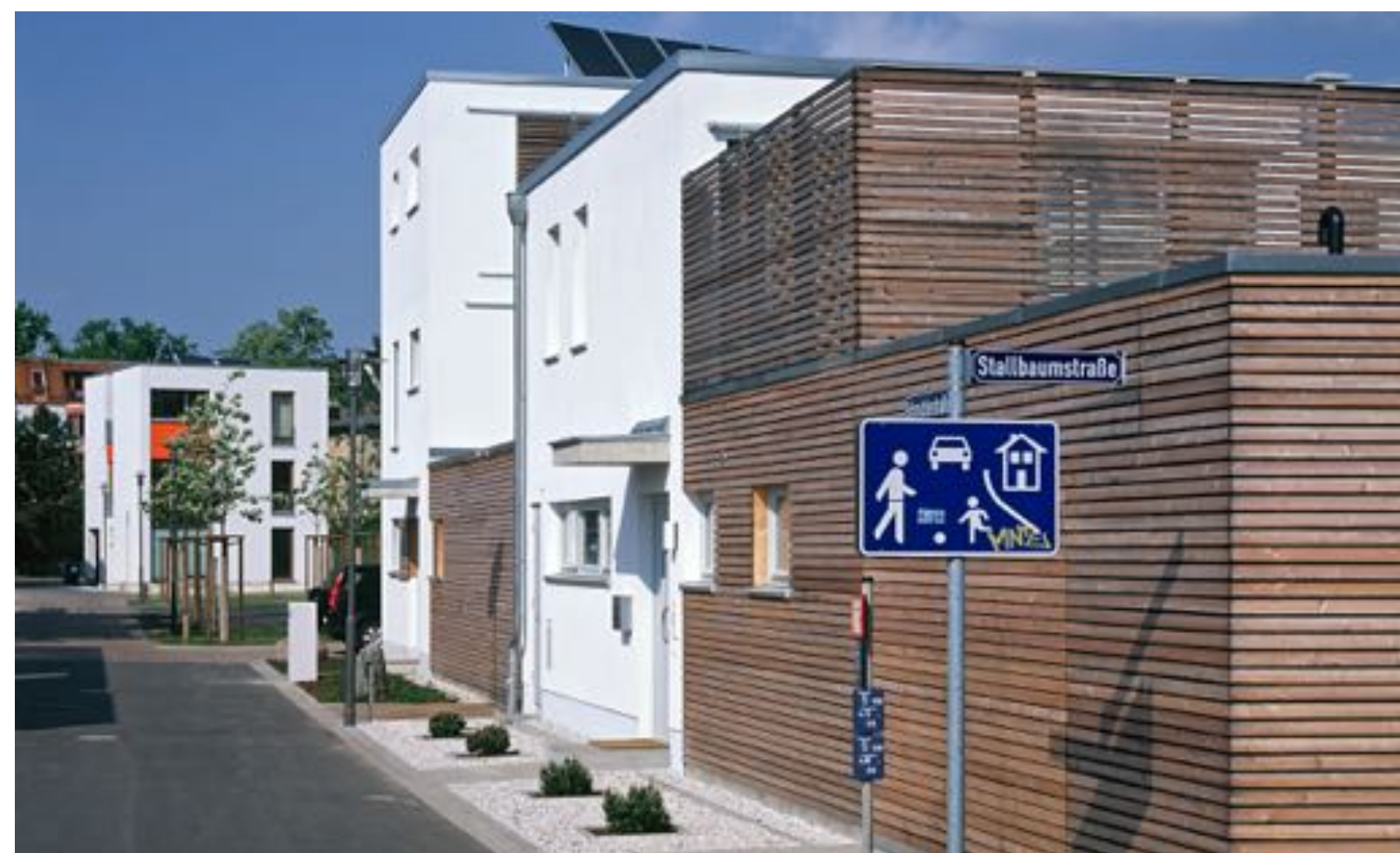
Wächterhaus Zschochersche Straße, Leipzig (oben) Foto Haushalten e.V.
