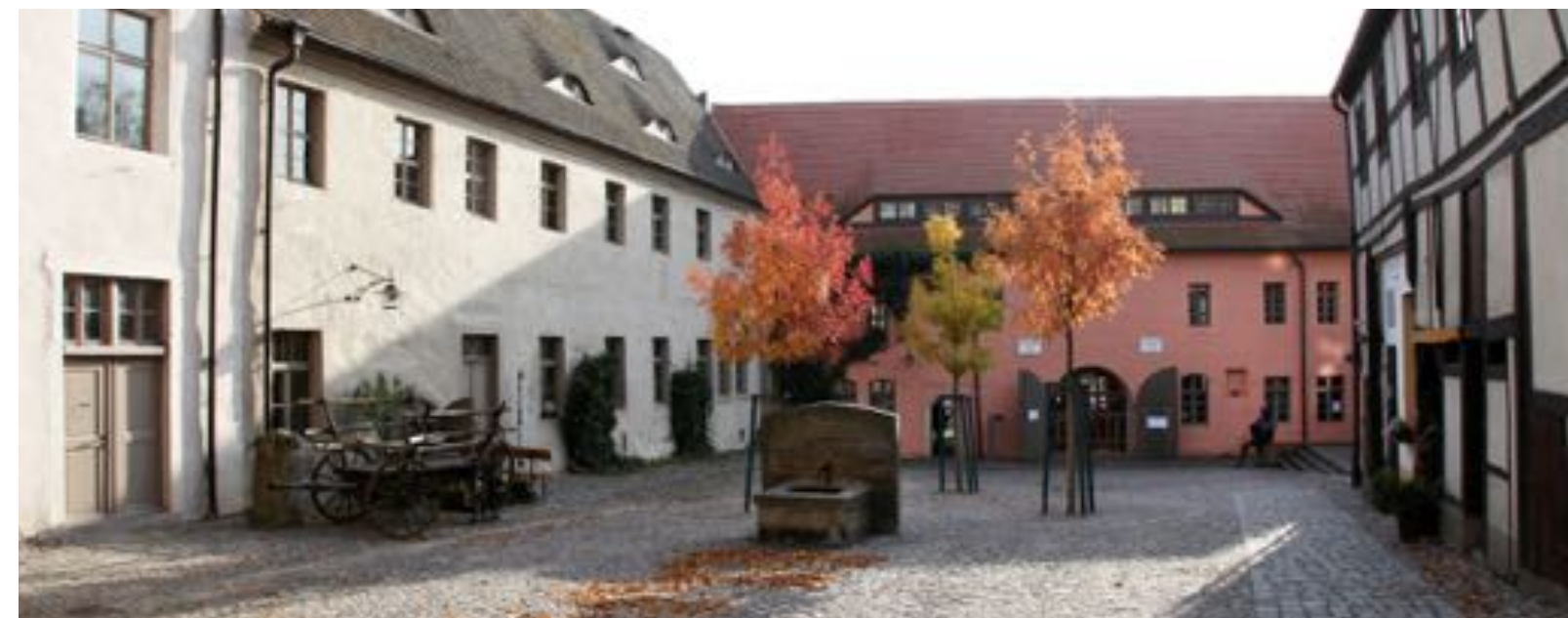
Cranach-Höfe Schlusstraße 1 vor und nach der Sanierung, Lutherstadt Wittenberg Fotos Johannes Winkelmann
