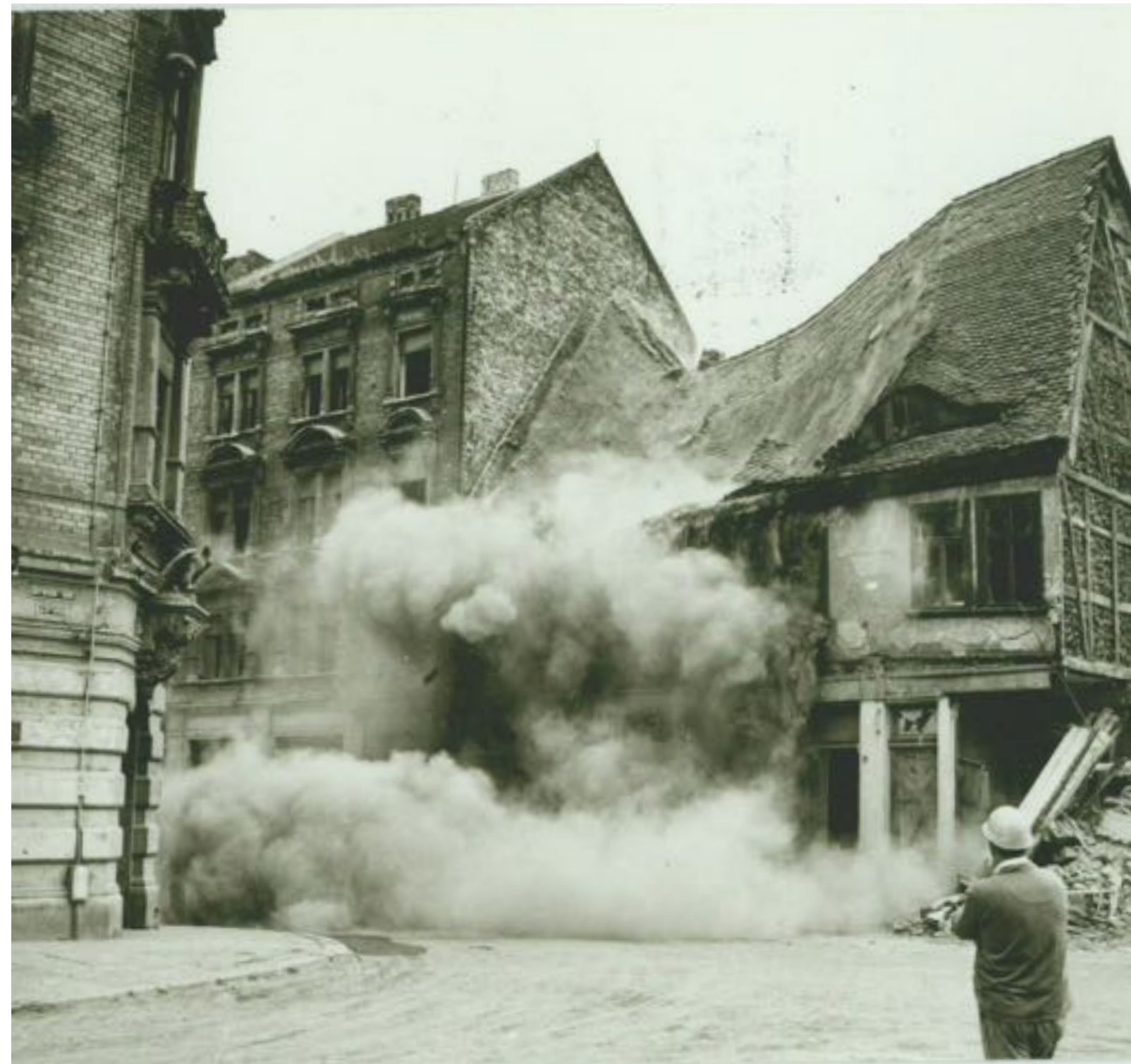
Abbrucharbeiten in der Geiststraße, Halle/Saale Foto Werner Ziegler
