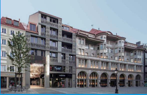
06 Passagieingang, Sendlinger Straße, Bauteil E/F
