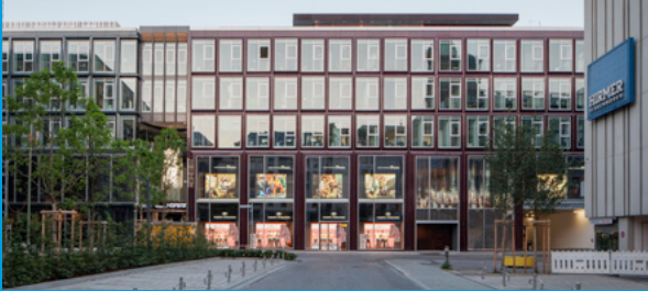
07 Passagieingang, Sendlinger Straße, Bauteil E/F
