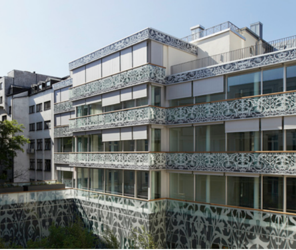
08 Hofansicht, Neubau, Bauteil B
