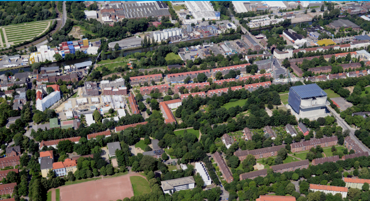
01 Luftbild Weltquartier während des Umbaus (Juli 2013)
