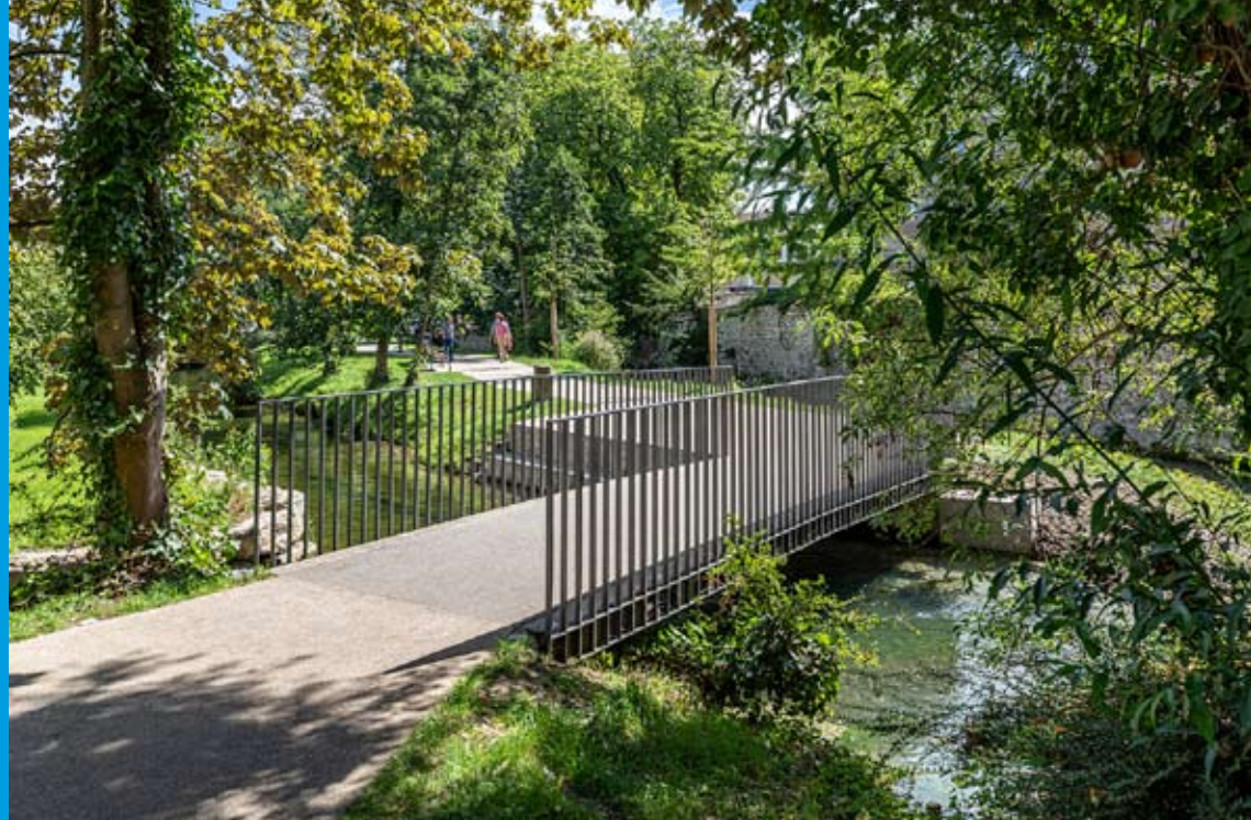
08 Querung der Flussarme
