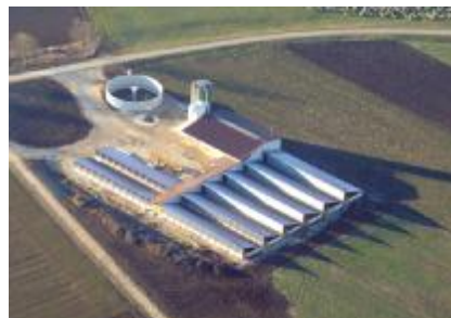
Abb. 14: Pilotbetrieb Hussel, neuer Schweinemaststall System „pig port
